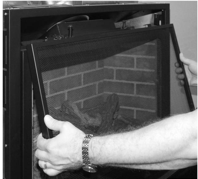
Étape 2 : Identifiez les deux petits goujons verticaux sur le firebox haut. Incliner légèrement l'écran vers le haut et l'aligner sur les trous de languette avec la Firebox goujons.
